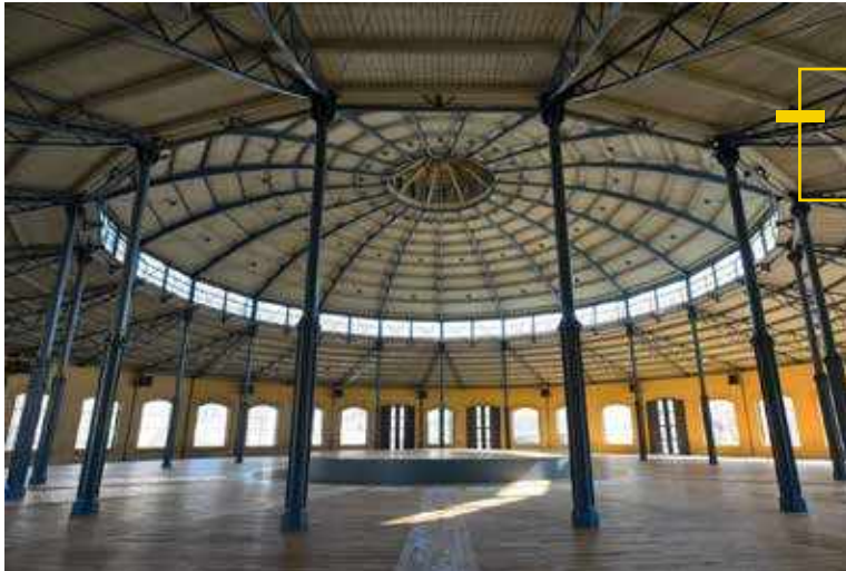
Rotonde 1 mit der Eisenkonstruktion und der Schwedlerkuppel
