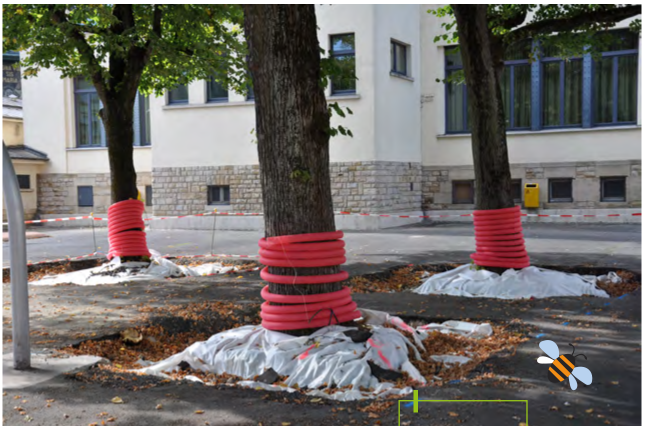
Entsiegelung in der rue des Ardennes
