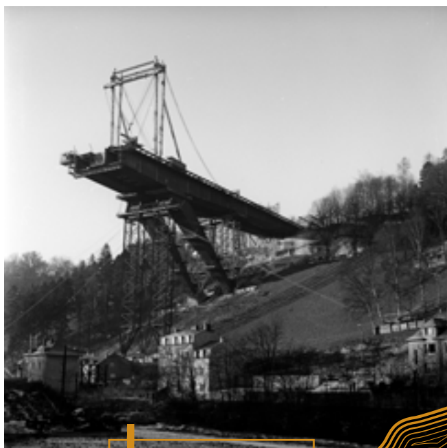
Le chantier du Pont Rouge (1963).
