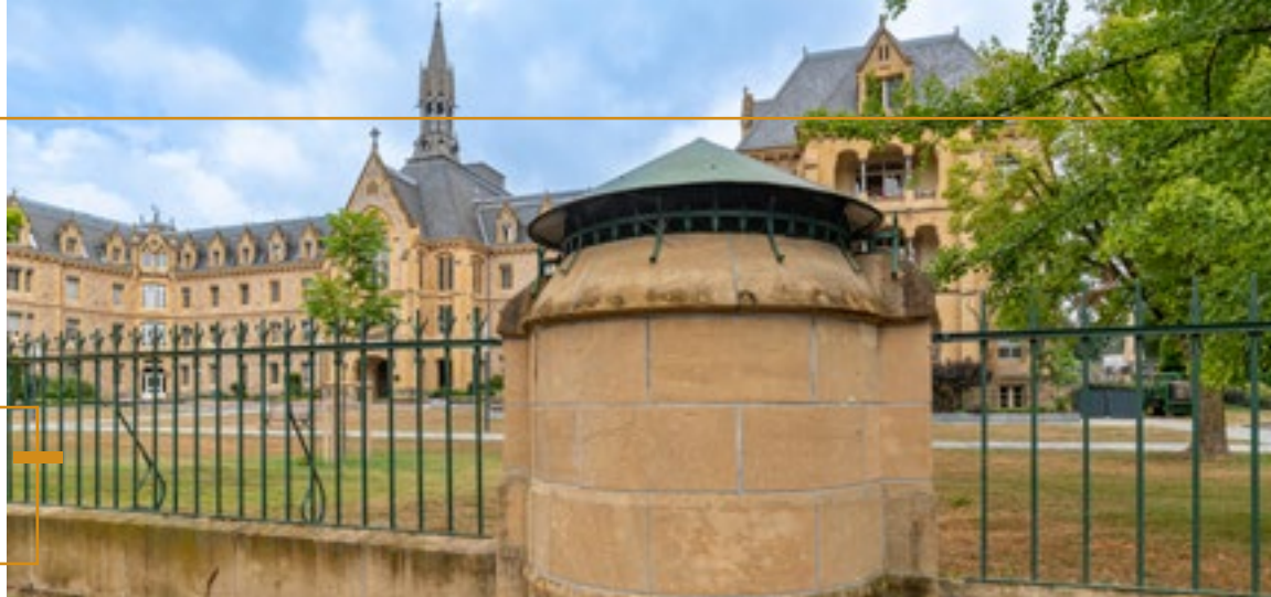
Fort Berlaumont: Entlüftungsschacht über dem Réduit.
