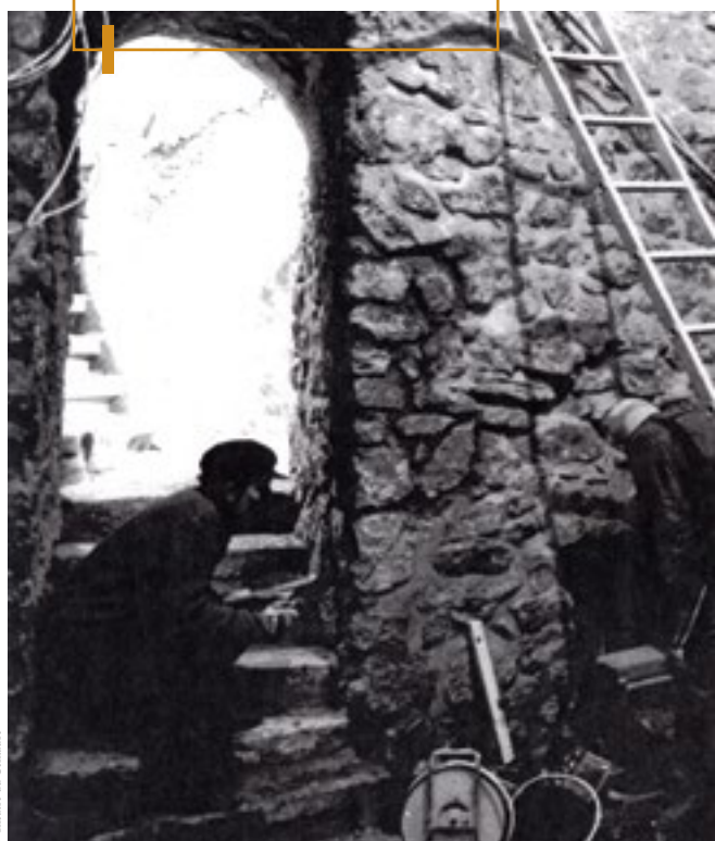
Différentes étapes du chantier au Théâtre du Centaure.
