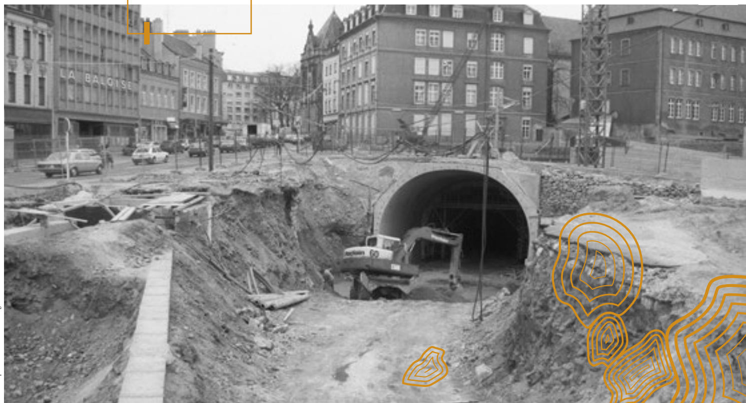
L'entrée du tunnel depuis le Viaduc.
