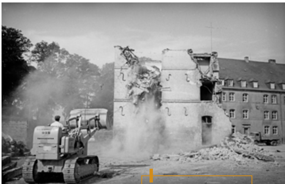
Démolition des casernes Plateau du Saint-Esprit (1964).
