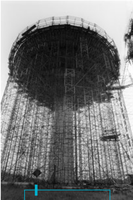
Bau des Wasserturms in Bonneweg-Kaltreis. (1983)
