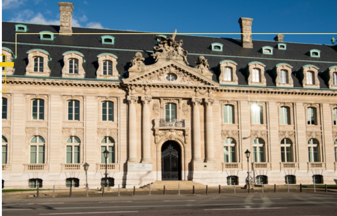
Bâtiment du 19Liberté
