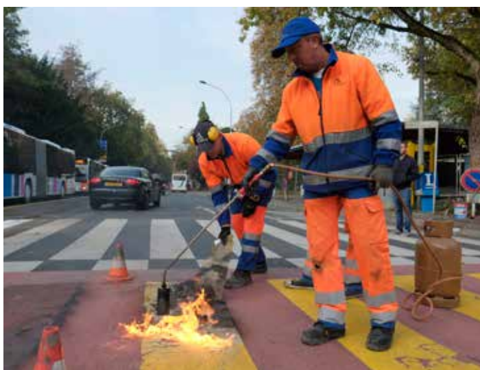
les bandes jaunes d'un passage pour piétons provisoire sont enlevées au brûleur.
