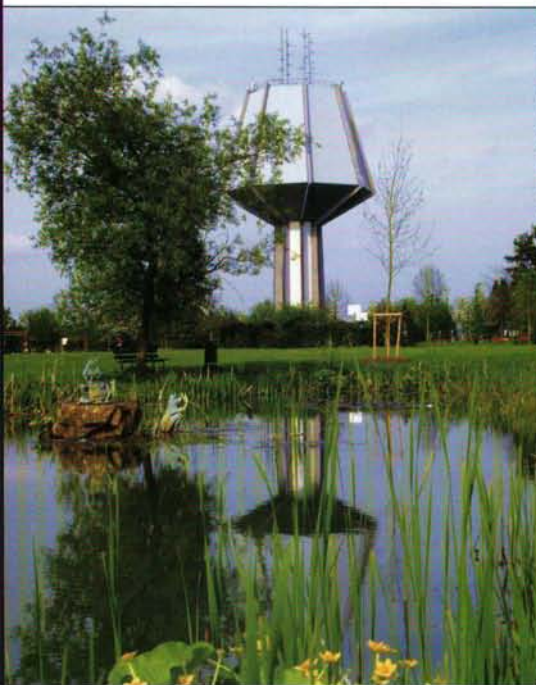
Wasserturm Kaltreis Fassungsvermögen: 2 000 m 3 Gesamthöhe: 40 m Inbetriebnahme: Juni 1987
