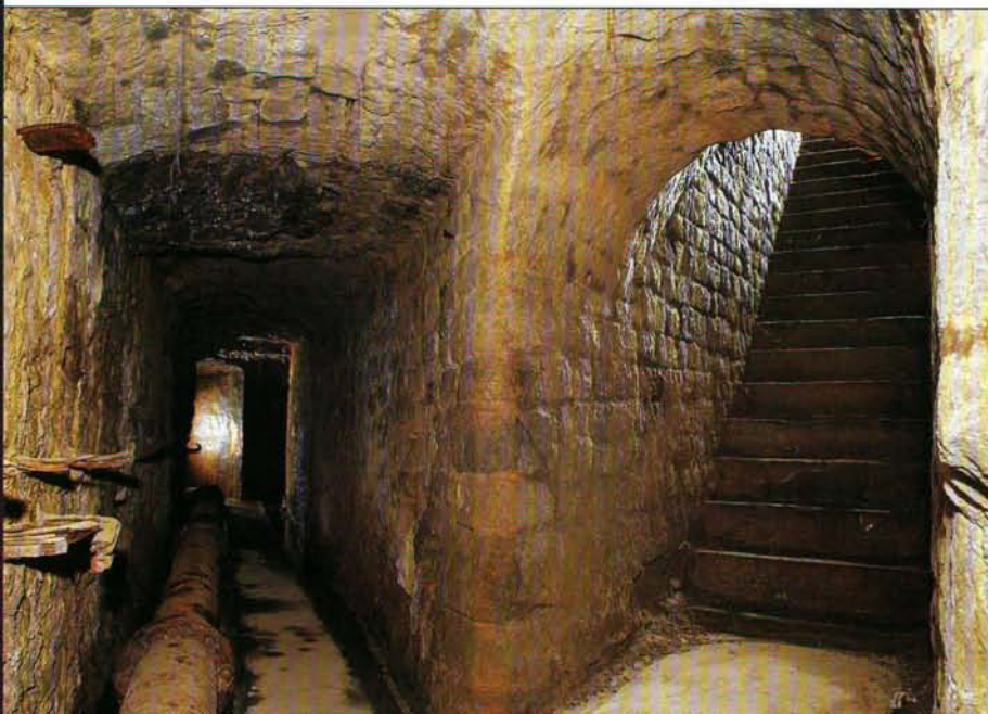
Eichtorquelle: Quellengang und Zugangstreppe
