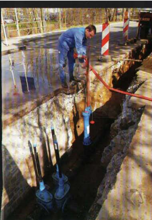
Entlüften und Spülen einer neuverlegten Netzleitung
