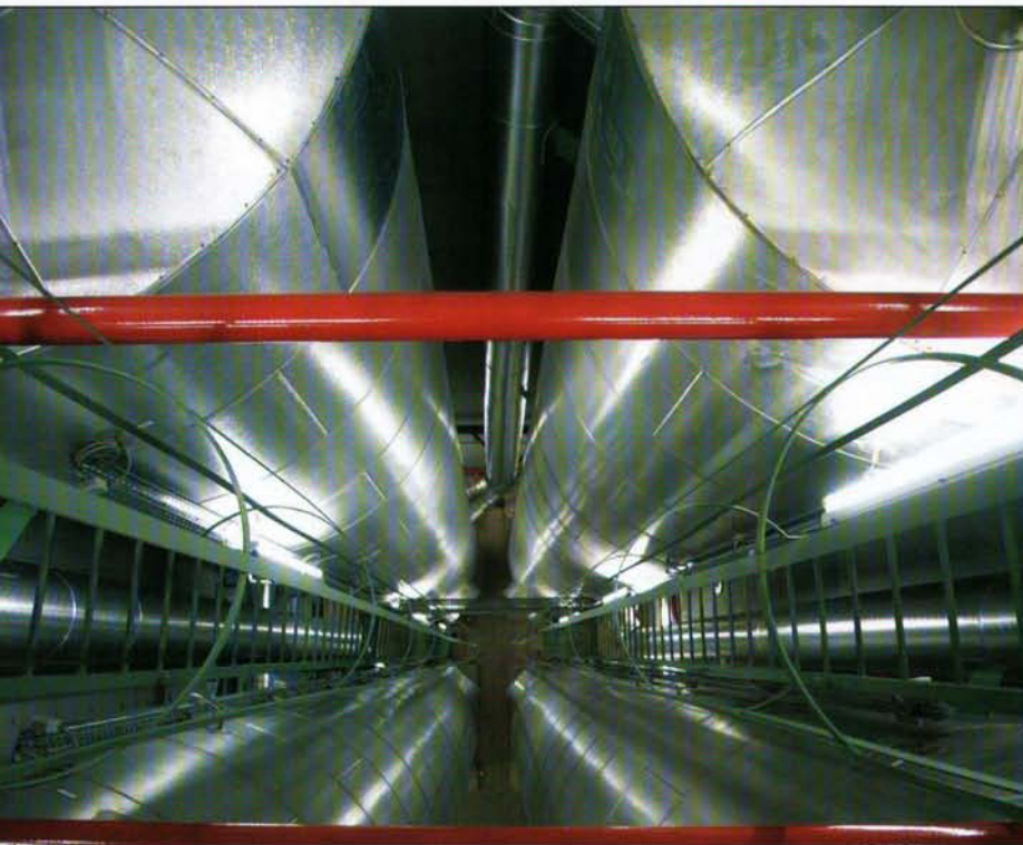
Ballons de stockage d'eau chaude
