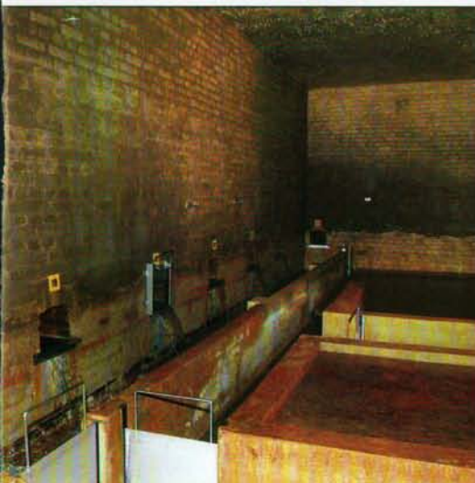
Glasbueren: Sammel- und Absetzbecken mit einer Schüttung bis zu 1 000 Fuder pro Tag
