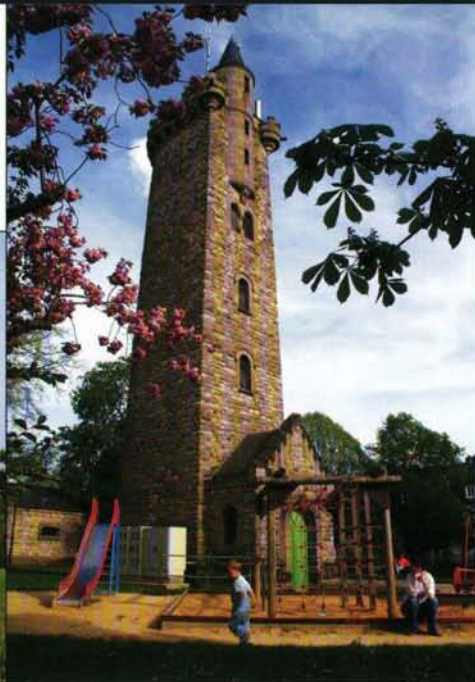
Der 1902 erbaute Limpertsberger Wasserturm (Höhe: 28 m) ist heute außer Betrieb und steht unter Denkmalschutz
