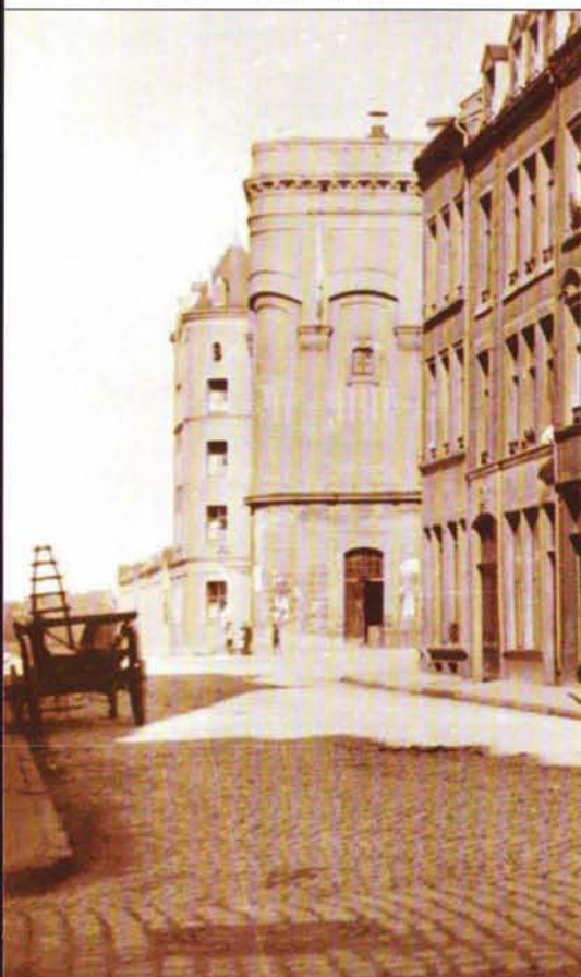
Wasserturm am Bäderplatz, 1880
