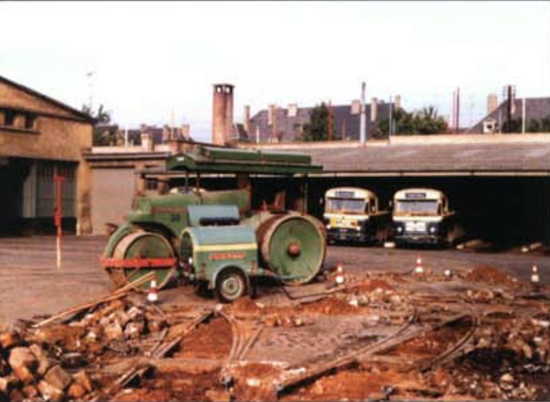
August 1970: Die Gleisanlage im Hof an der Victor Hugo-Avenue wird ausgebaut und anschließend die Schwarzdecke erneuert
