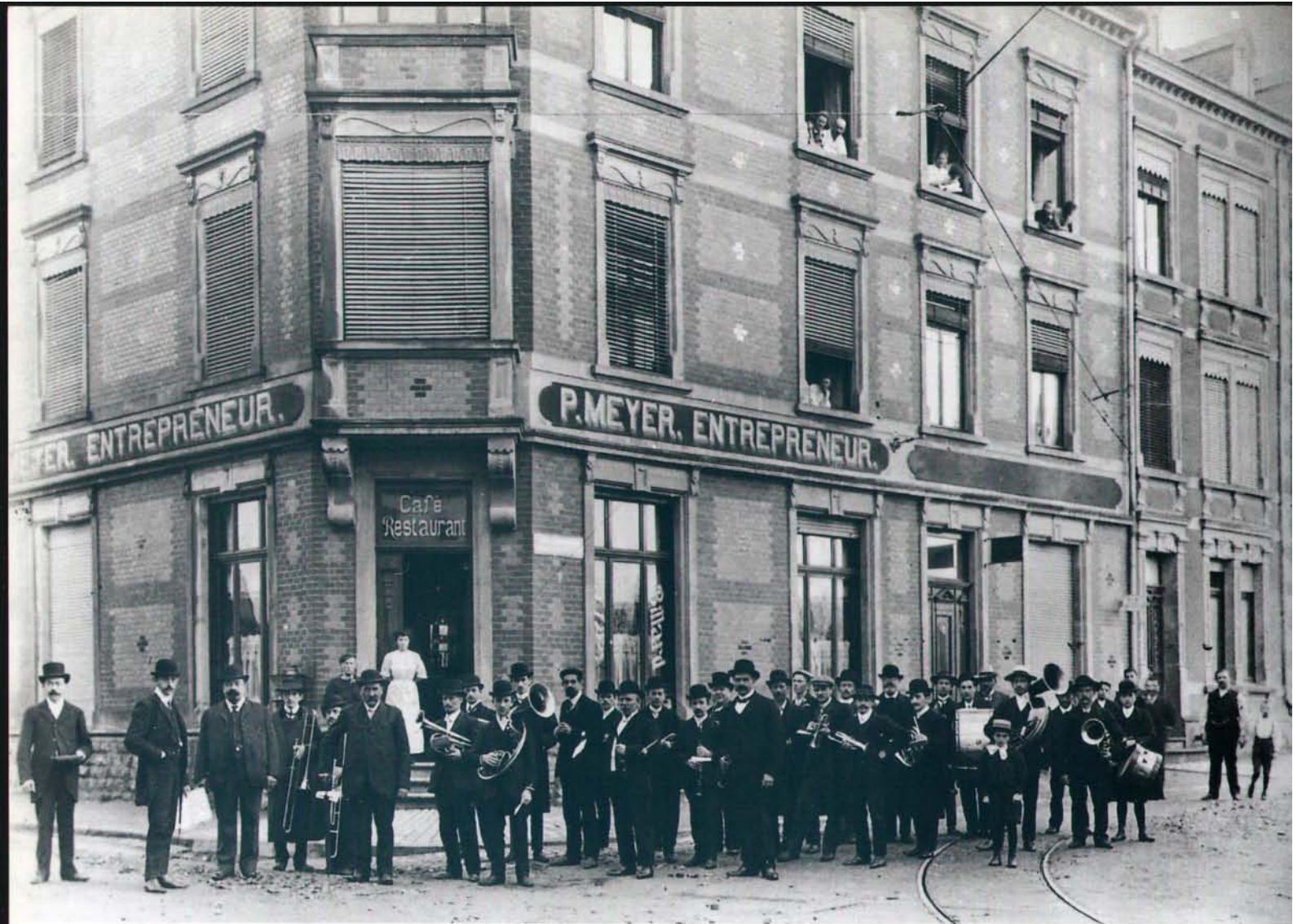
Rue Ermesinde, Harmonie de Limpertsberg, 1908
