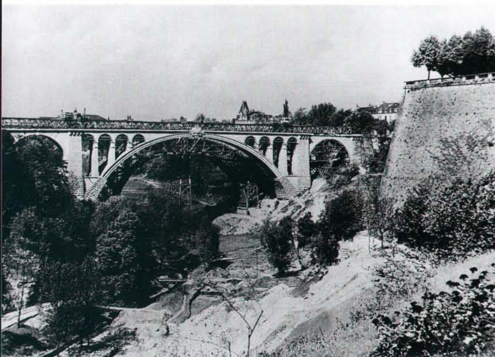
Der Bau der Adolphe-Brücke (1900-1903)
