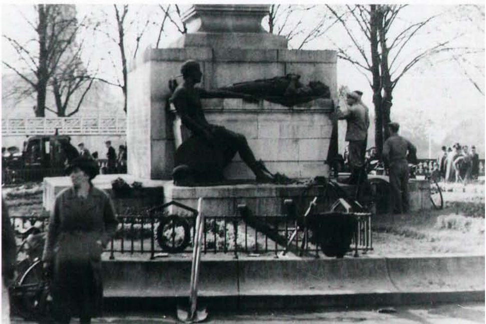
Der Beginn der Abrißarbeiten
