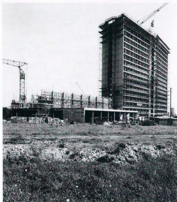
15.5.1964: Richtfest am „Héichhaus“
