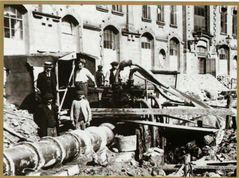
Verlegung des Hauptkollektors in Stadtgrund im Jahre 1920. Im Hintergrund erkennt man die „Händschefabrik“
