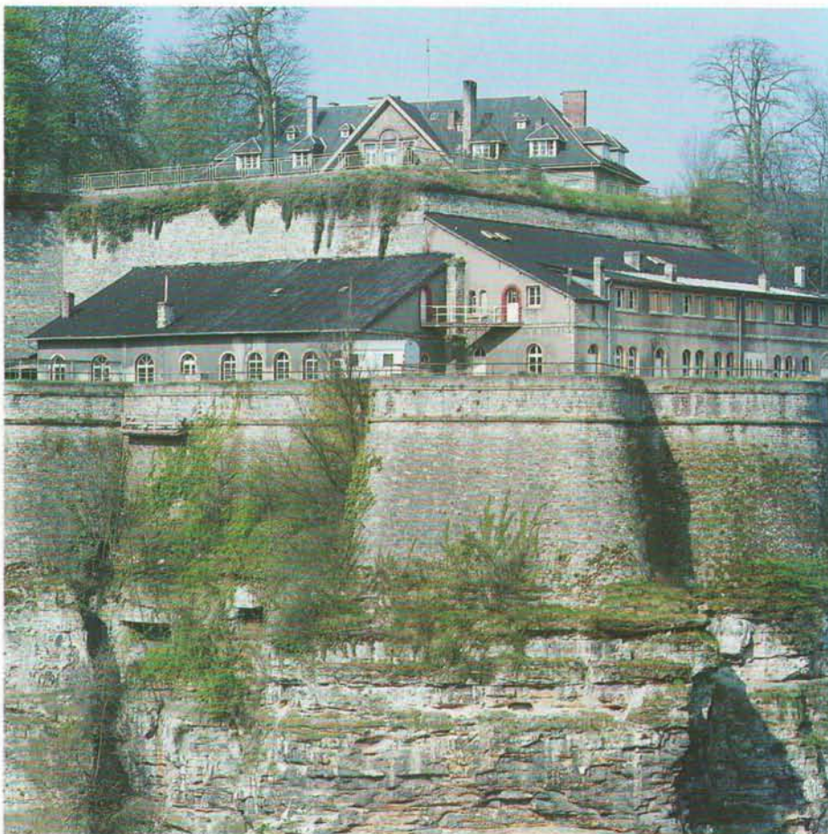
Ecuries avant la démolition
