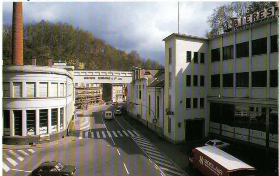
Die Anlagen der Henri-Funck-Brauerei in Neudorf
