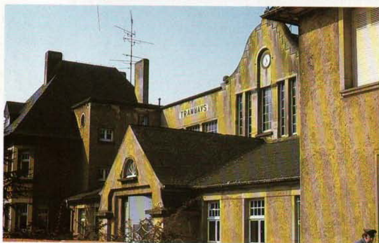
Dépôt de tramways, Limpertsberg
