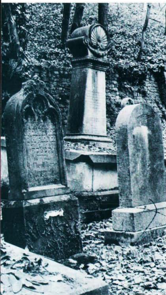
Le cimetière avant la restauration
