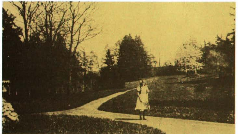
Der Park der Handschuhfabrik (1895)
