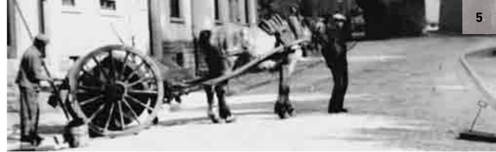
Vidange manuelle des bouches d'égout vers 1920 / Manuelle Reinigung der Straßengullys um 1920
