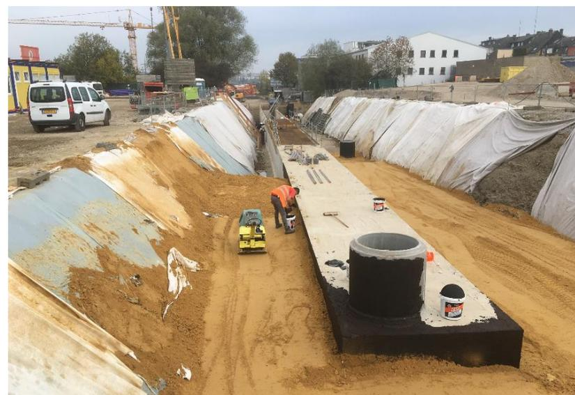
Chantier PAP Monopol route d'Esch: Construction du bassin de rétention pour eaux pluviales
