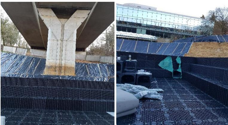
Pose des pièces modulaires et "emballage" à l'aide de membranes étanches et résistantes, fermées avec des soudages performants
