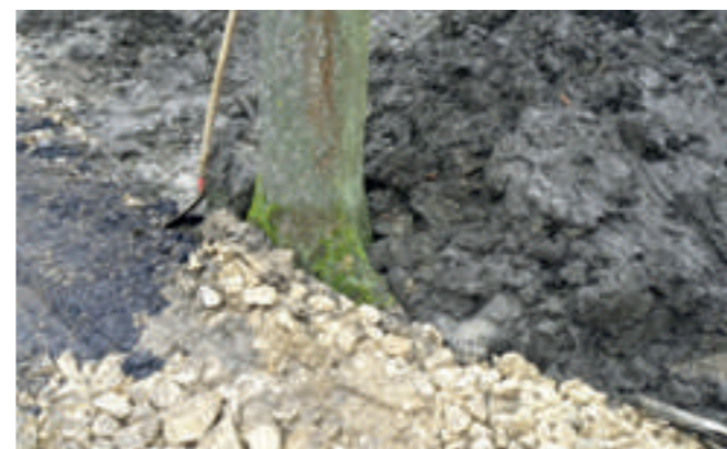
Aucune protection n'a été mise en place ici.
