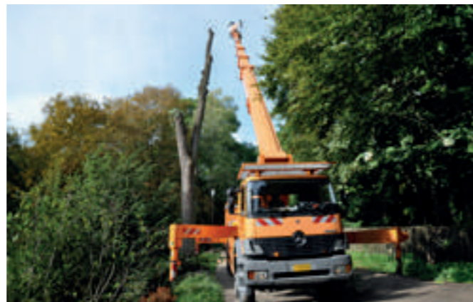
Grande plateforme de travail élévatrice lors de travaux d'abattage dans le parc municipal, hauteur de travail maximale de 45 mètres.
