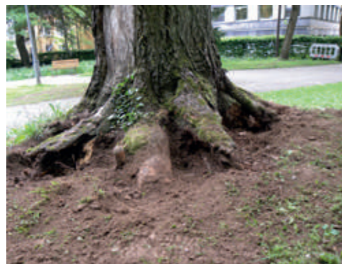
Le contrôleur d'arbres a remarqué une irrégularité à la base du tronc. En fin de compte, l'arbre a dû être abattu, car il n'était plus stable.
