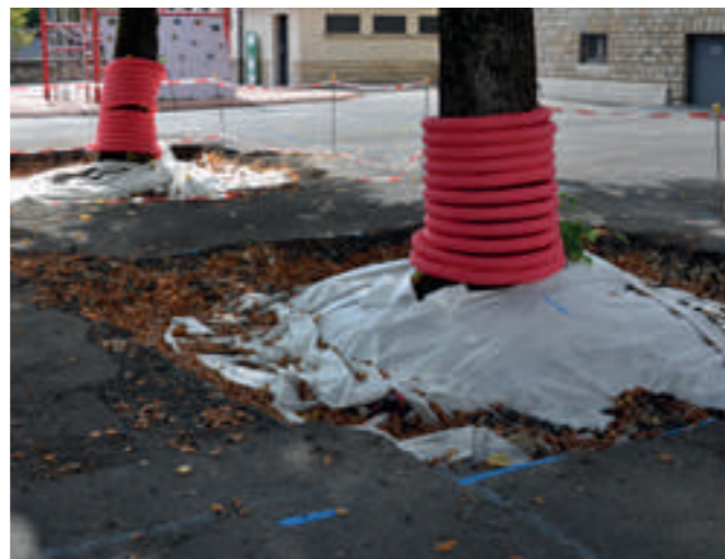
Protection des arbres dans une cour d'école, Rue des Ardennes, Bonnevoie
