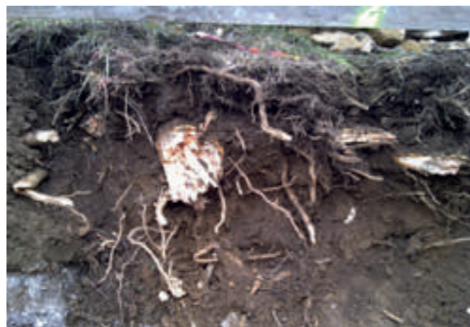
Ces racines sont irrémédiablement endommagées. Elles sont mises à nu et s'assèchent.
