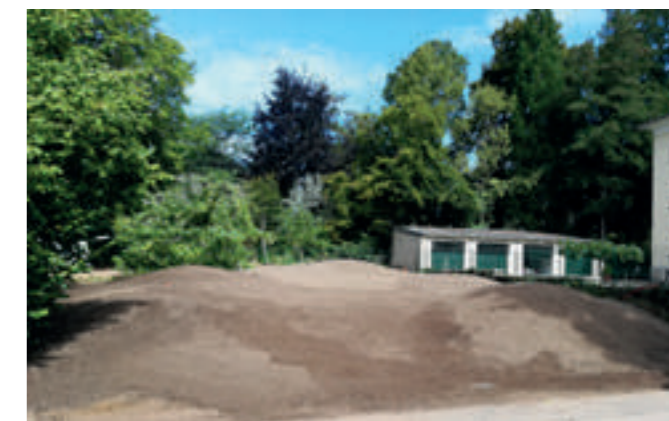
Travaux de terrassement, puis de plantation en 2020
