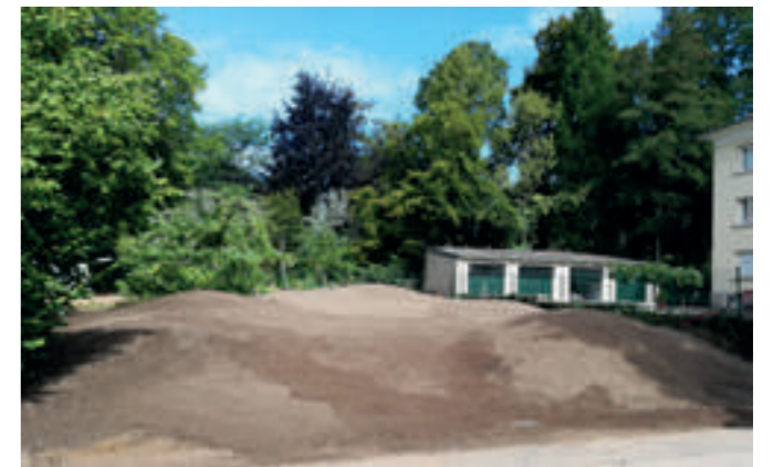
Bodenarbeiten und später auch Pflanzarbeiten im Jahr 2020
