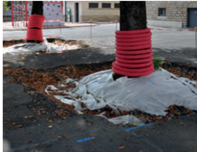
Baumschutz im Schulhof, Rue des Ardennes, Bonneweg
