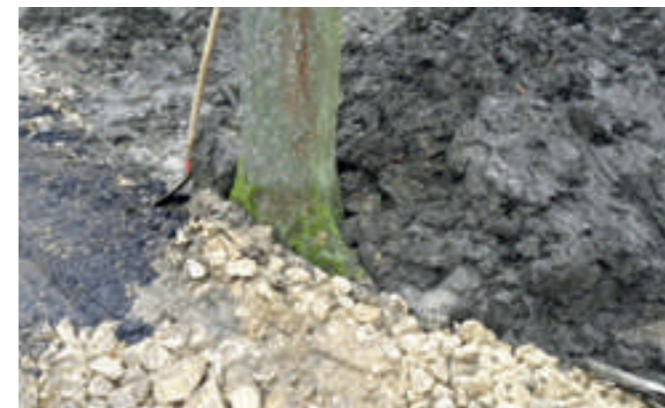
Hier wurde kein Baumschutz erstellt.
