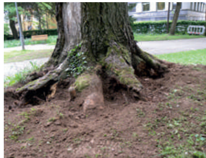
Dem Baumkontrolleur ist eine Unregelmäßigkeit am Stammfuß aufgefallen. Letztendlich musste der Baum aufgrund dieses Ergebnisses gefällt werden, da er nicht mehr standfest war.
