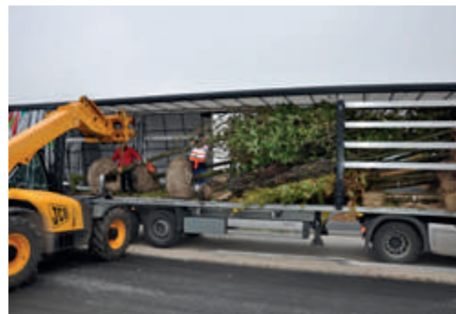
Rue Anatole France in Bonneweg / Entladen auf der Baustelle
