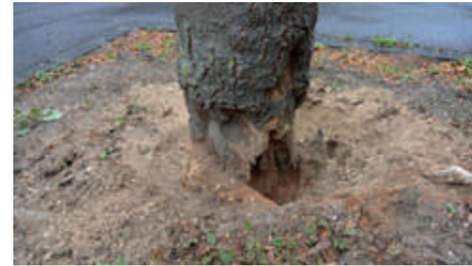
Freigelegter Stammfuß eines Bergahorns 7 : Die visuelle Baumkontrolle gab Anlass zu dieser Grabung. Der Baum musste gefällt werden, da seine Standsicherheit nicht mehr gewährleistet war.
