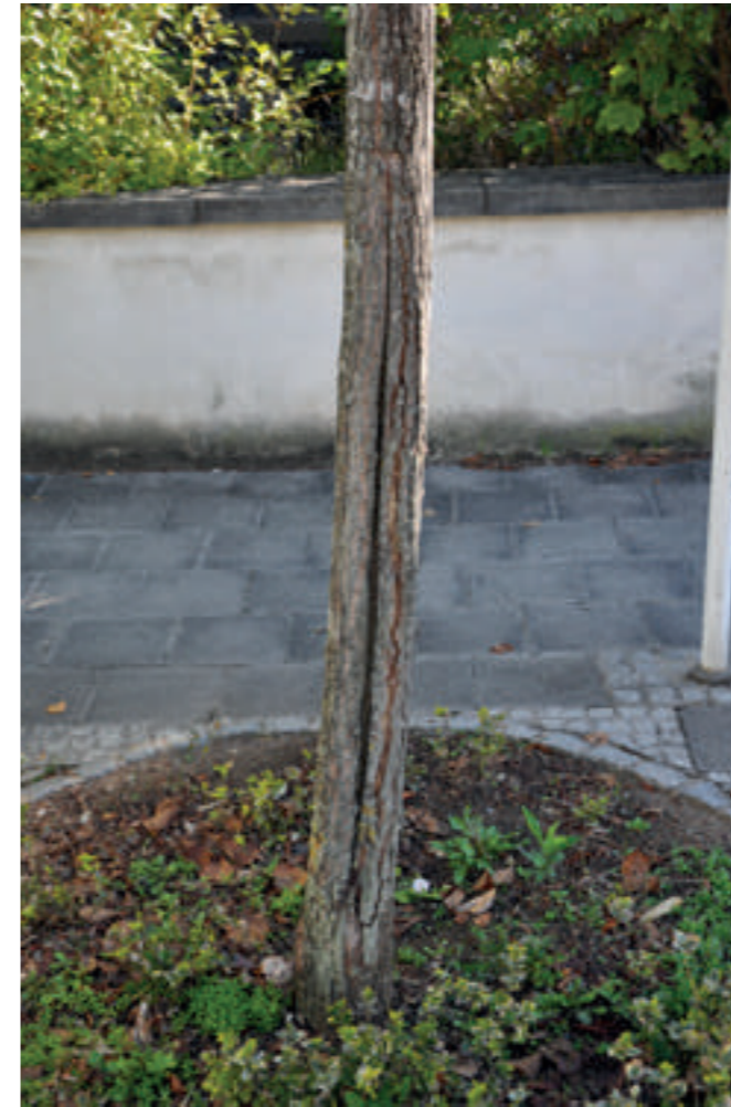
Bedingt durch die Sonneneinstrahlung und den Trockenstress, Der Stamm ist der Länge nach aufgerissen. Obwohl er versucht, den Schaden zu überwallen, bleibt im Stamminneren immer die Schwachstelle einer 'Wunde', die dem Baum in den folgenden Jahrzehnten nicht mehr die Stabilität bietet wie ein intakter Stamm.
