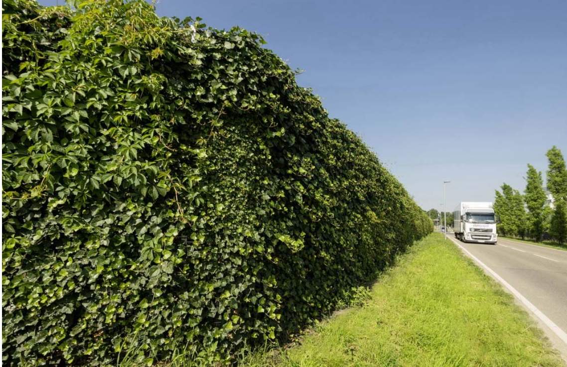
Abbildung 25: Beispiel für eine begrünte Lärmschutzwand
