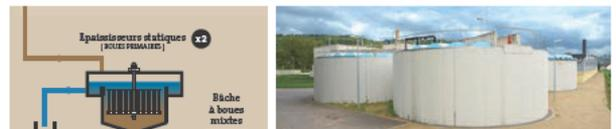
**7 Flottation** - Les boues issues du traitement biologique sont traitées par flottation. Il s'agit d'une injection de micro bulles au cœur des boues qui a pour effet la flottation d'une partie des boues et la décantation accélérée de l'autre. Les boues ainsi épaissies à 50 g/l sont envoyés avec les boues primaires sur l'usine de traitement des boues existante.
