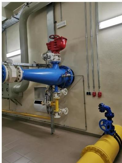
Installation d'une sonde pour contrôler la turbidité en permanence de l'alimentation SEBES. En cas de turbidité le Service Eaux a la possibilité d'évacuer l'eau dans le vidange.
