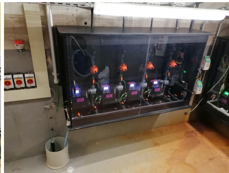
Armoire de dosage \text{NaOH}_1
