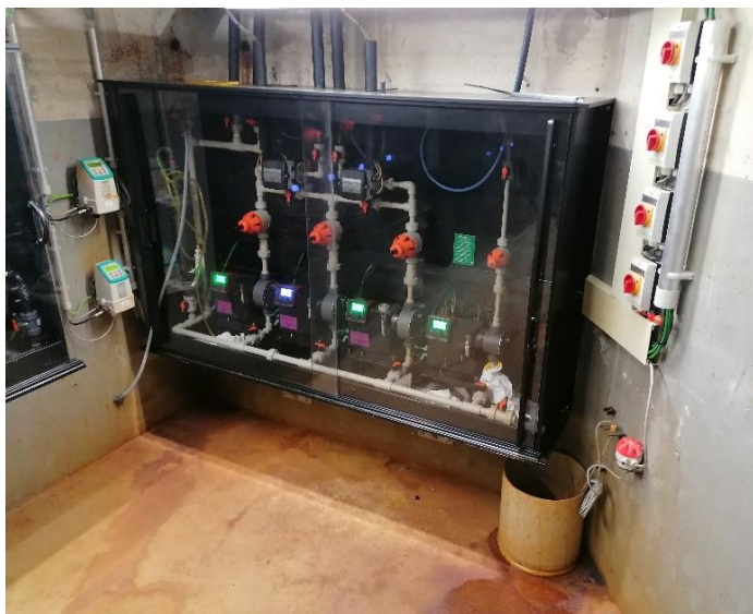
Armoire de dosage \text{FeCl}_3
