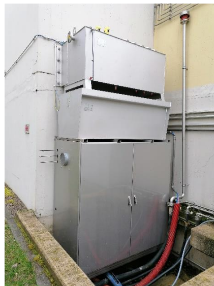
Armoire de dosage Methanol
