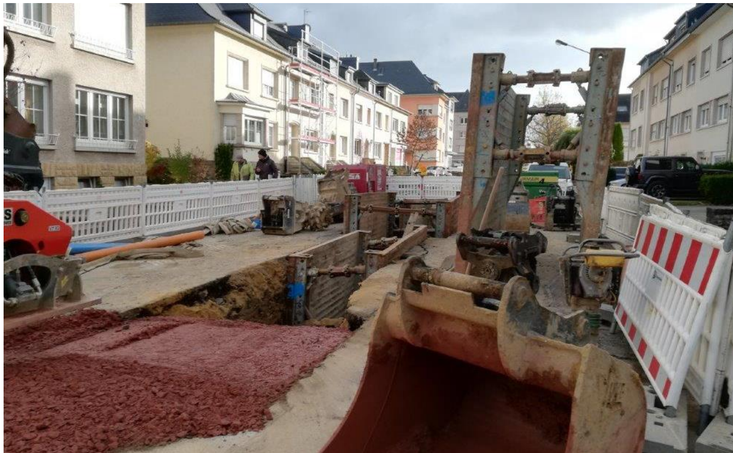
Reconstruction de la canalisation dans la rue de Pont Rémy
