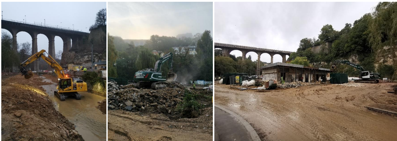
Modelage des berges / démolition/ dépollution de l'ancien bâtiment Minigolf
