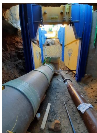
PAP Aubépines – pose de canalisations et profilage des bassins de rétentions ouverts
