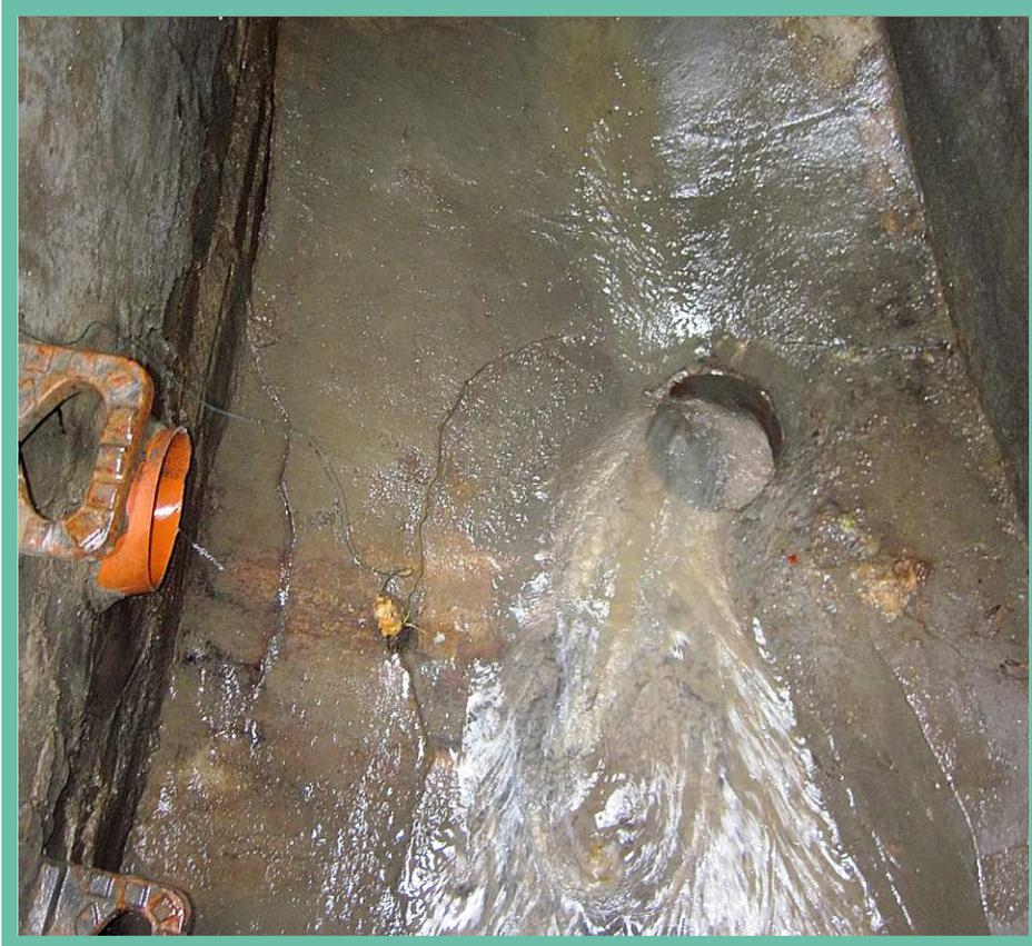
► Photo: exemple d'un ouvrage de déversement
