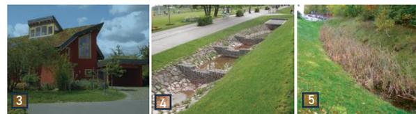
Figure 2: Exemples de rétention et d'écoulement superficiels des eaux pluviales au sein d'un PAP, source : Leitfaden für den natürlichen Umgang mit Regenwasser in Siedlungsgebieten Luxemburgs (AGE)
