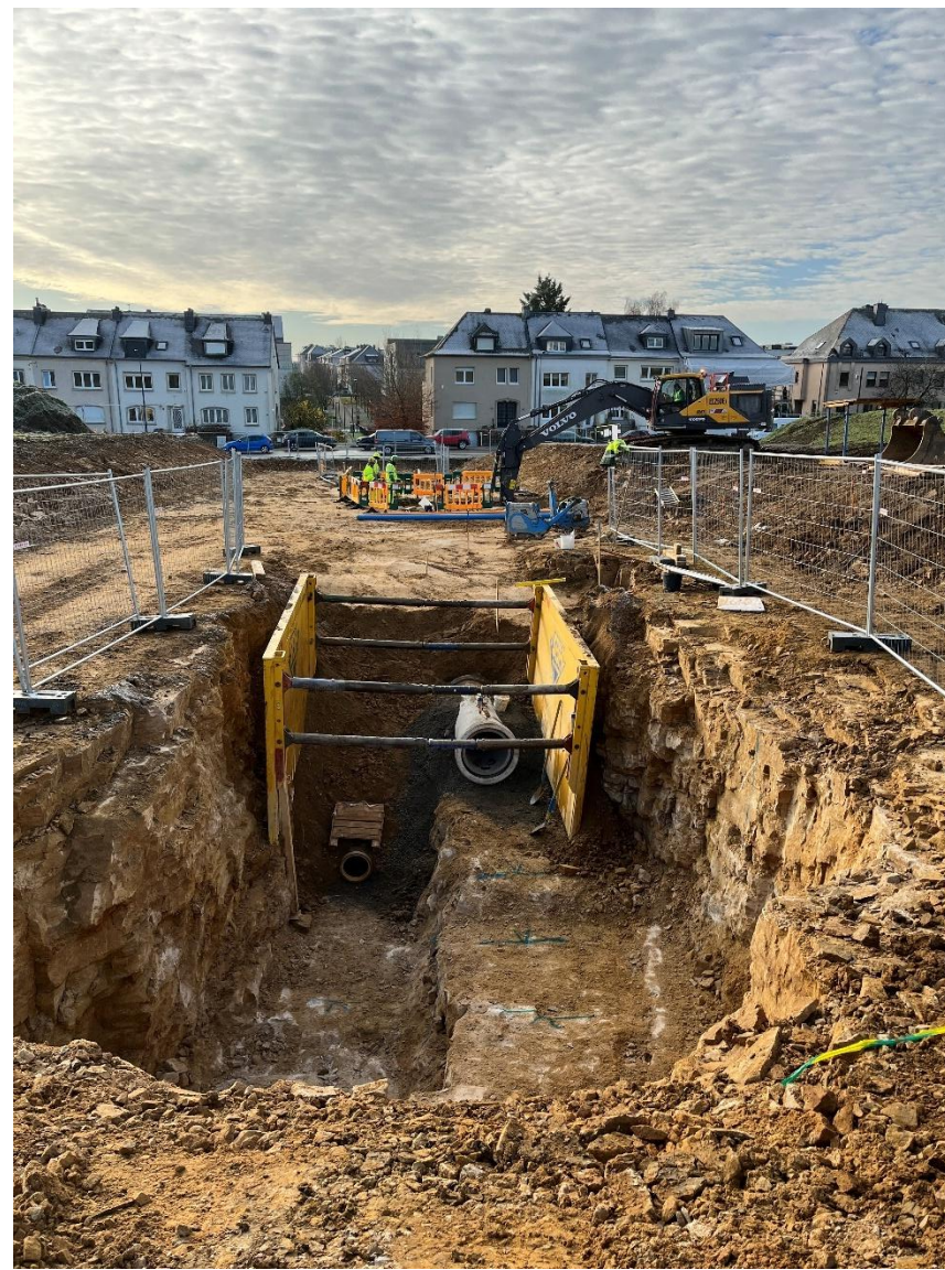
PAP Itzegerknupp - construction d'un bassin de rétention et des canalisations pluviales et eaux usées
