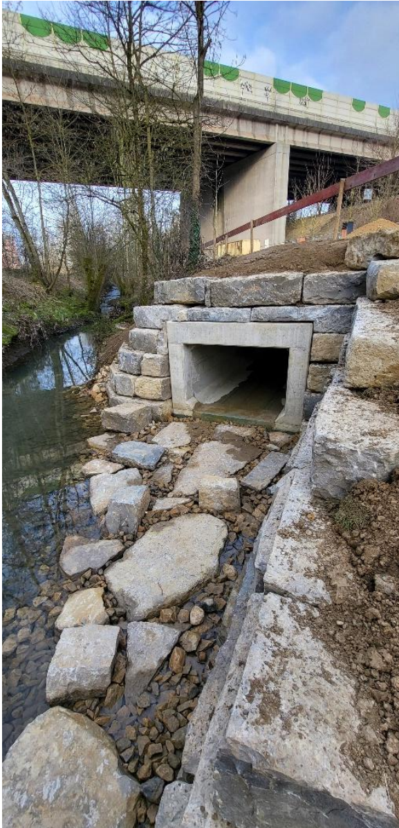
Mise en conformité de la station de pompage Helfenterbrück – Nouveau déversoir dans le Merlerbach et dégrilleur
