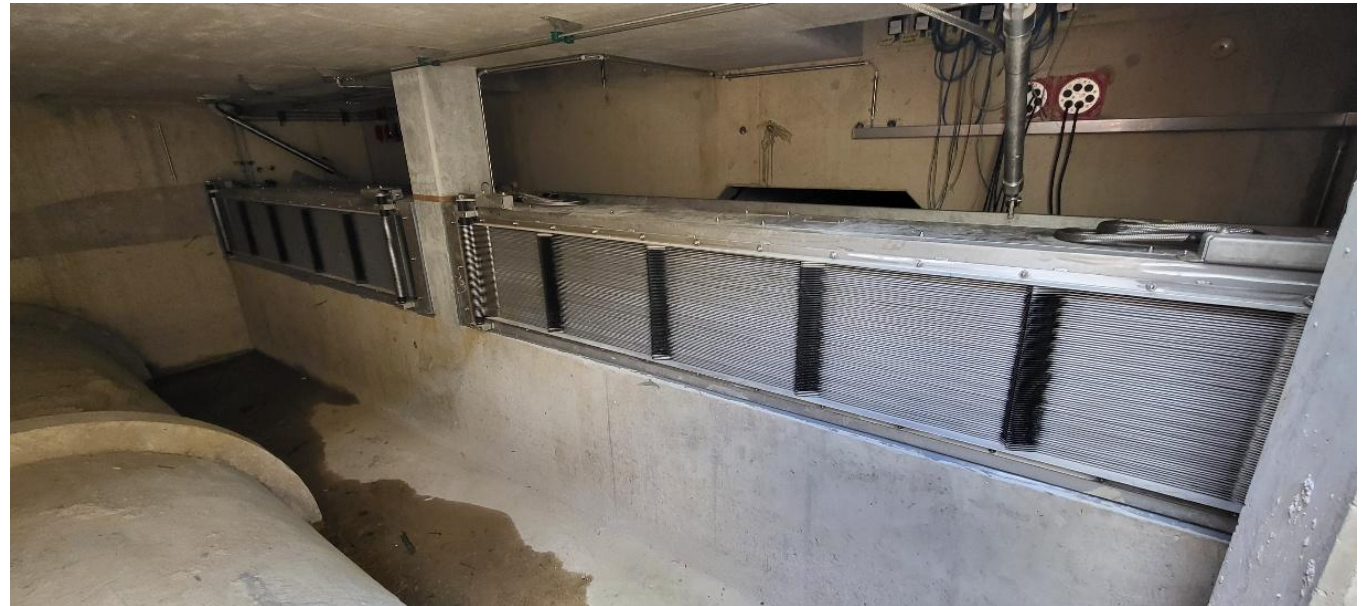
Mise en conformité de la station de pompage Helfenterbrück – Nouveau déversoir dans le Merlerbach et dégrilleur
