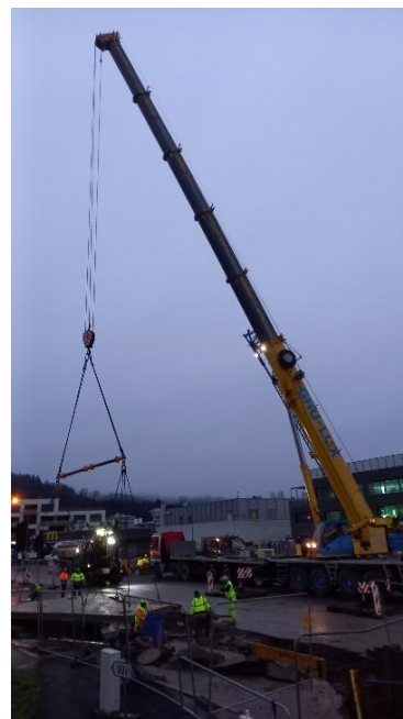
Rue du Pont à Bereldange - renouvellement des collecteurs à l'entrée de la Station d'épuration
