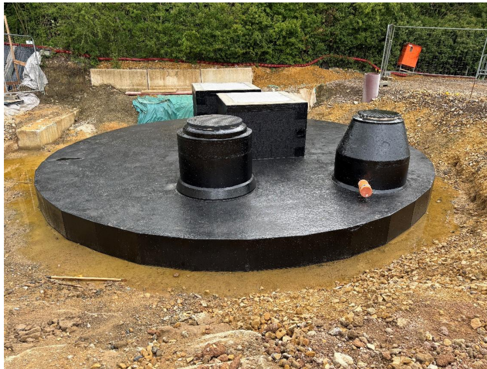
Travaux en cours – situation juillet 2025
