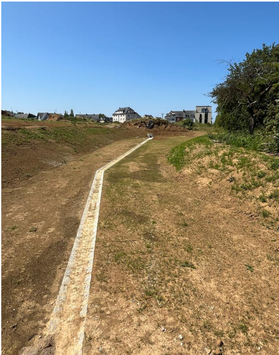
PAP Itzegerknupp - construction d'un bassin de rétention et des canalisations pluviales et eaux usées
