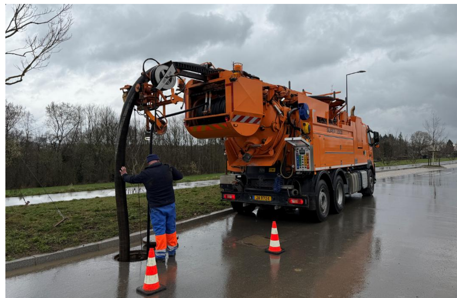
Equipe d'entretien et de curage des canalisations
