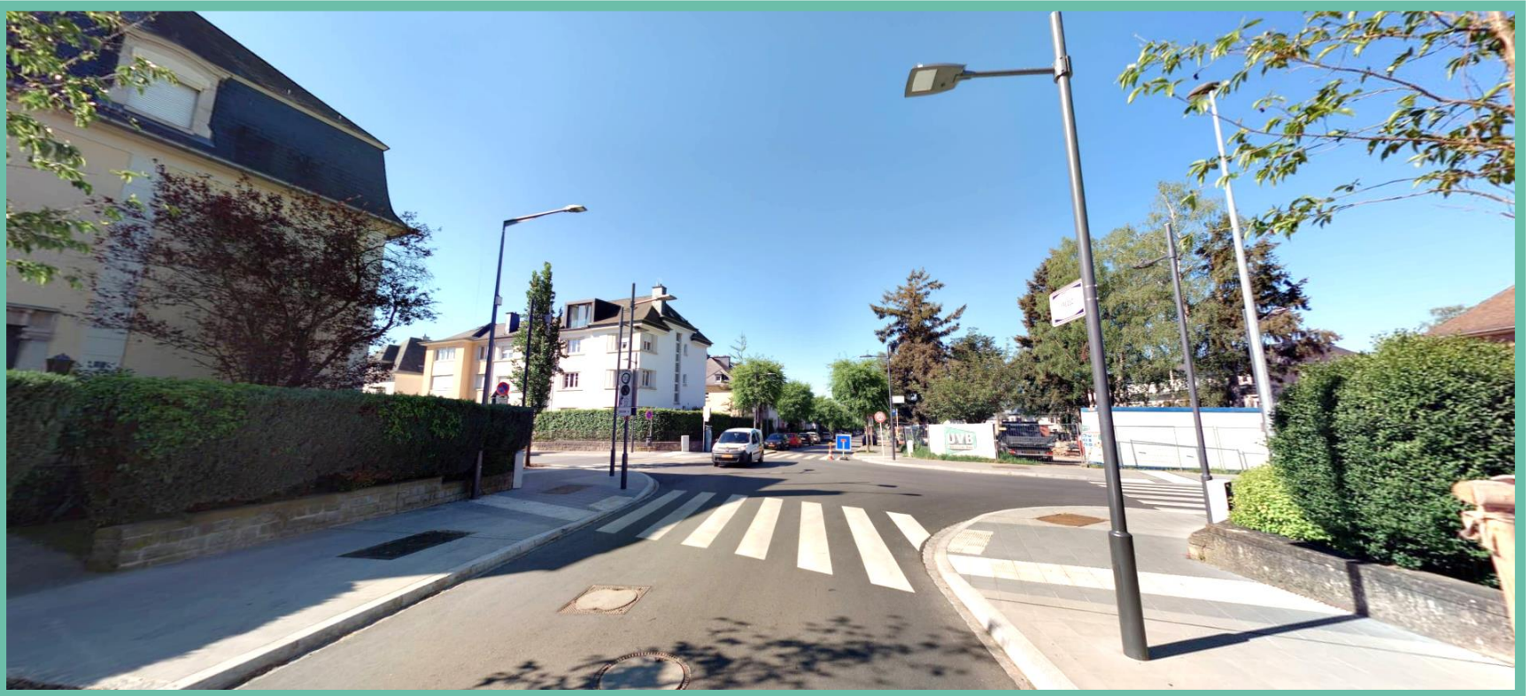
► Photo: Rue Jean-Baptiste Fresez - Exemple d'un passage piéton avec éclairage d'appoint et dalles podo-tactiles
