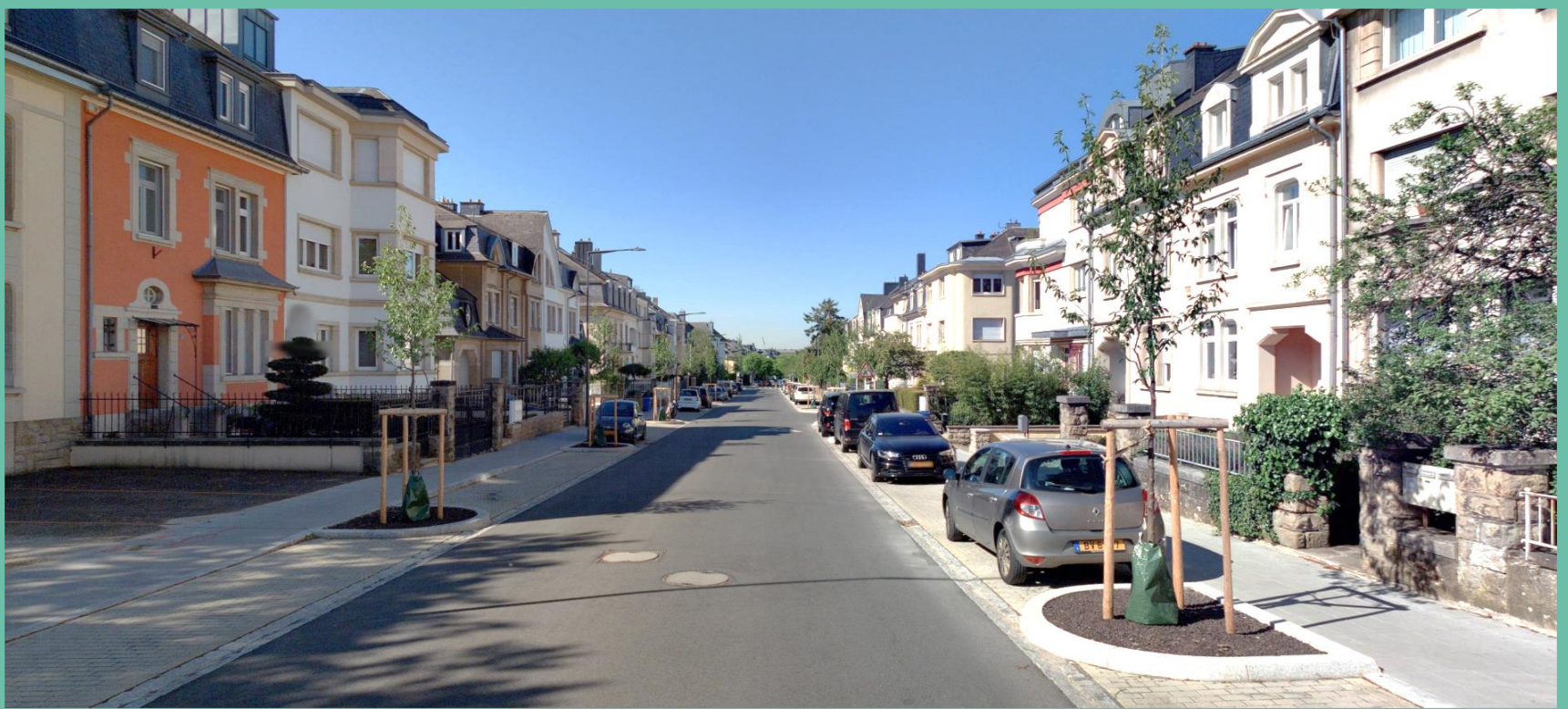
► Photo: Rue Jean-Baptiste Fresez en 2020 - après le réaménagement
