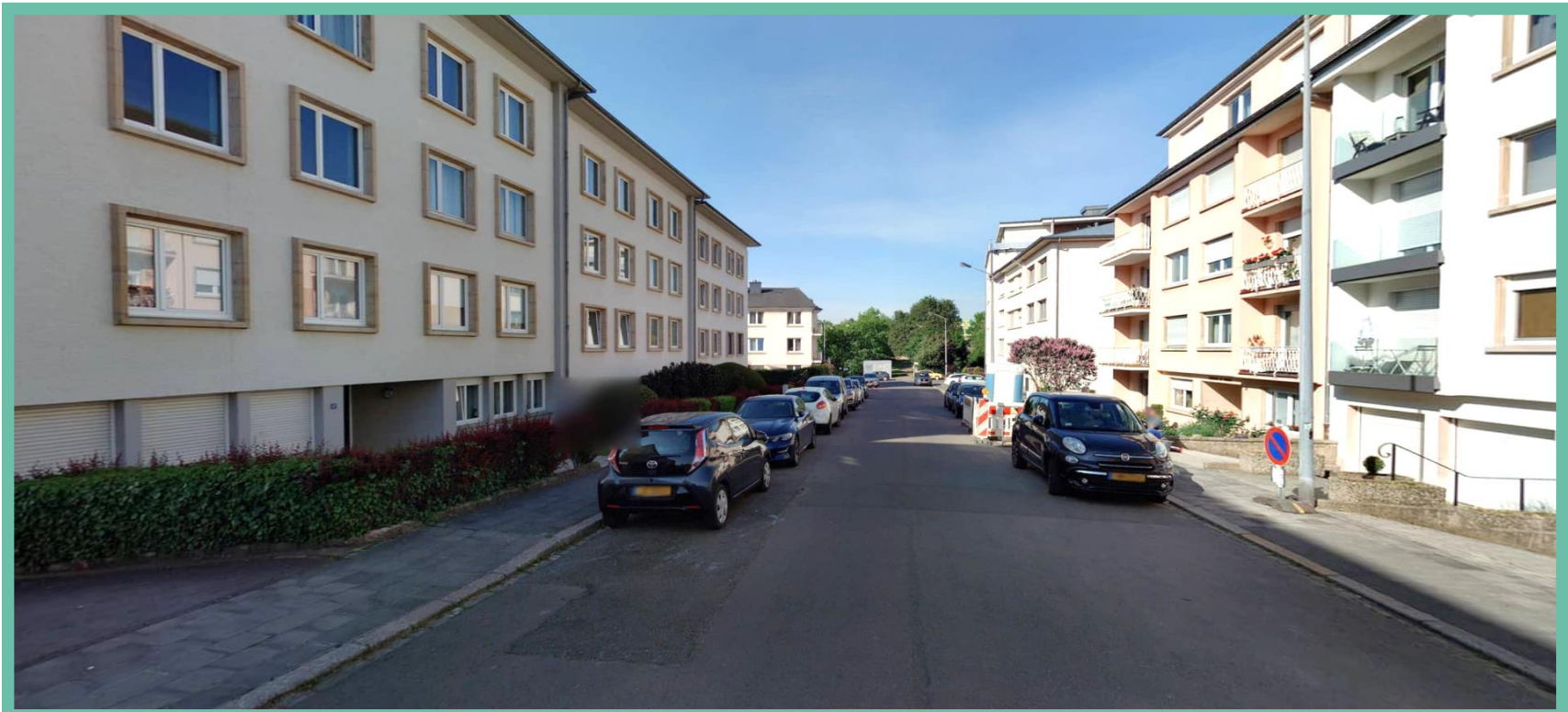
► Photo: Rue de Vianden – Tronçon C (entre les immeubles n°44 – n°56)
