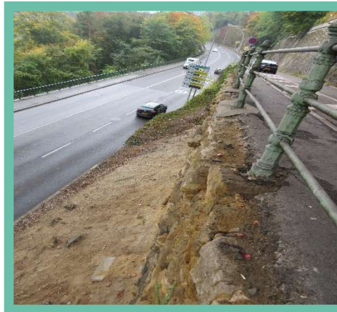
► Blvd Paul Eyschen - mur et talus
