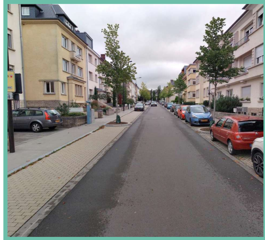
► Exemple: Rue Evrard Ketten après les travaux
