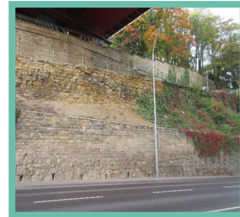
► Blvd Paul Eyschen - mur et talus
