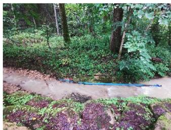
Lors des travaux de rénovation de la source B9/B10, la sortie de la conduite de vidange a été modifiée afin de la rendre à nouveau conforme aux réglementations en vigueur.
