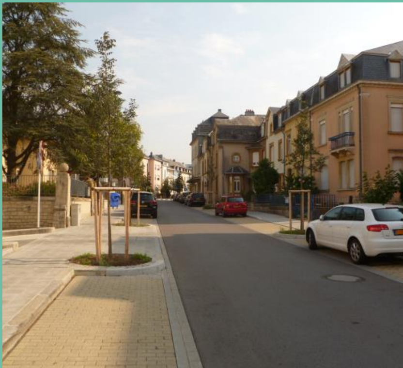
► Exemple: Rue Ermesinde avant les travaux
