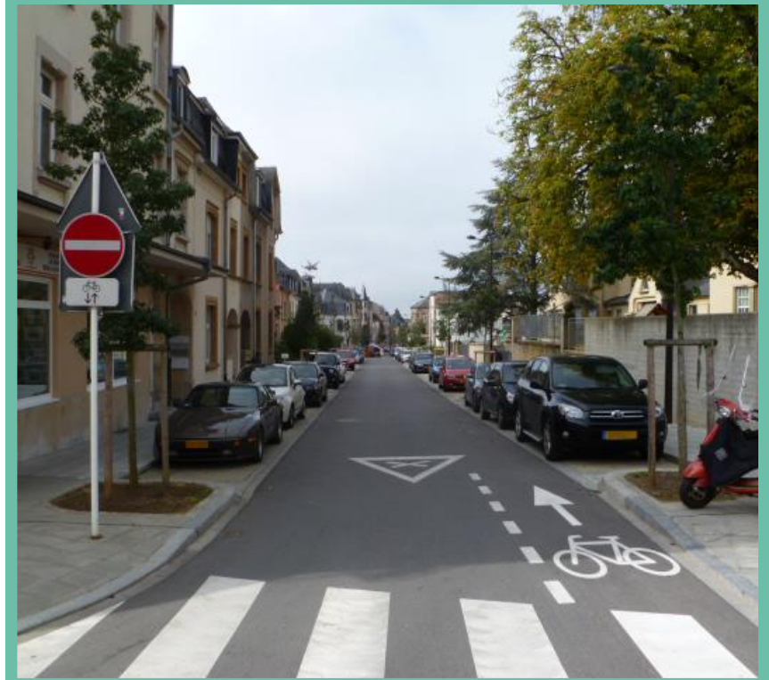
► Exemple: Rue Ermesinde après les travaux
