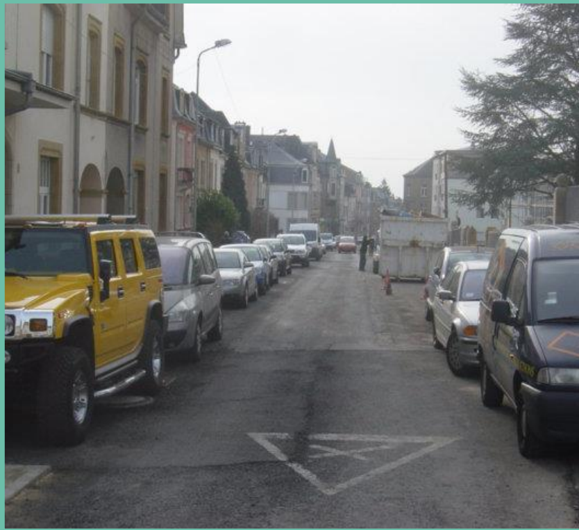
► Exemple: Rue Ermesinde avant les travaux
