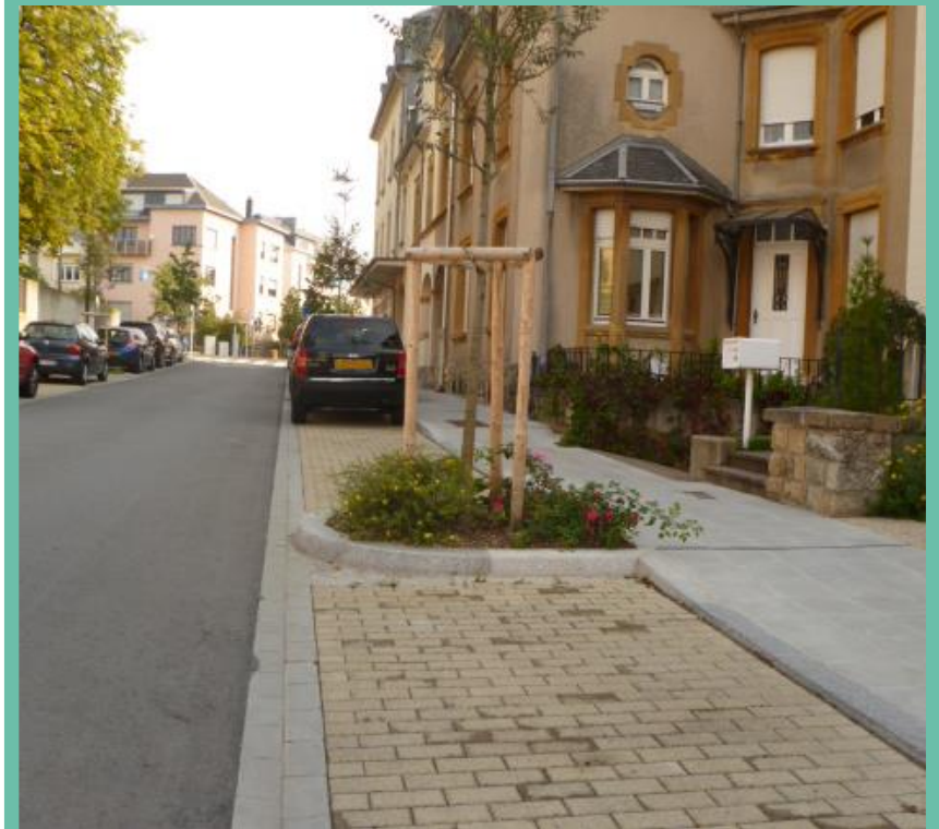
► Exemple: Rue Ermesinde après les travaux
