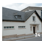
Hollerich Salle de gymnastique rue de l'Abattoir T 4796-1
