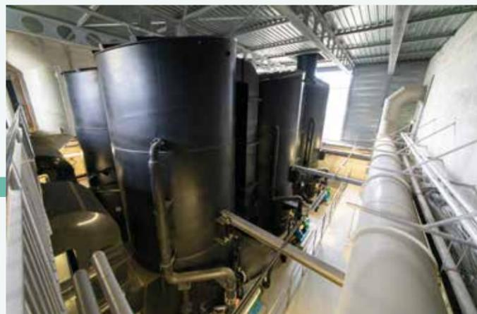
L'air pollué est collecté dans les différents bâtiments moyennant un réseau de gaines et envoyé par des ventilateurs dans la gaine d'alimentation de l'unité de traitement d'air. Ici, l'air est lavé chimiquement par passage successif dans trois tours.
