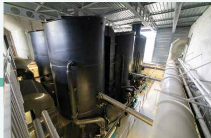
Die verunreinigte Luft aus den verschiedenen Gebäuden wird über Luftschächte gesammelt und mithilfe von Ventilatoren der Luftreinigungsanlage zugeführt. Dort wird die Luft nacheinander in drei Türmen chemisch gereinigt.
