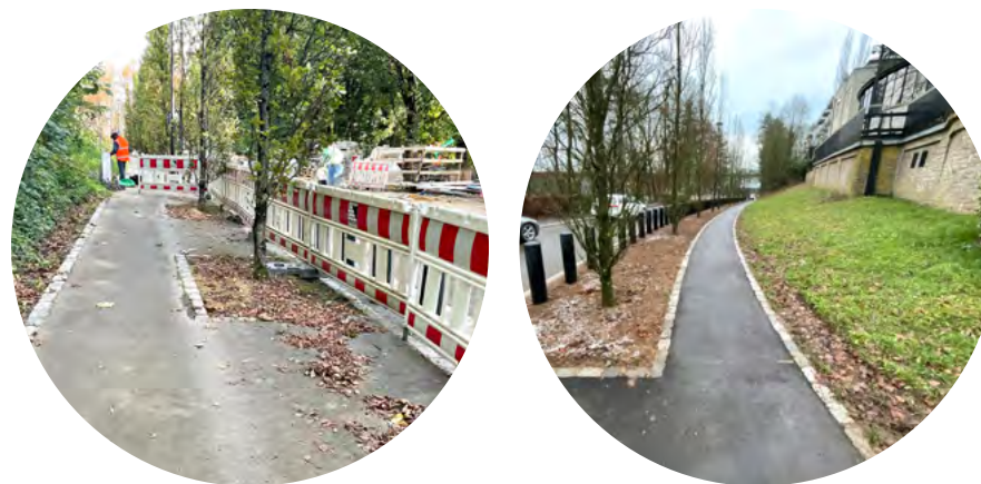
Figure 8 : Exemple Bvd Paul Eyschen avant et après travaux de réduction de scellement - Source : Service Voirie
