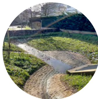
Figure 4: PAP Vivre sans voiture - Source: Service Canalisation
