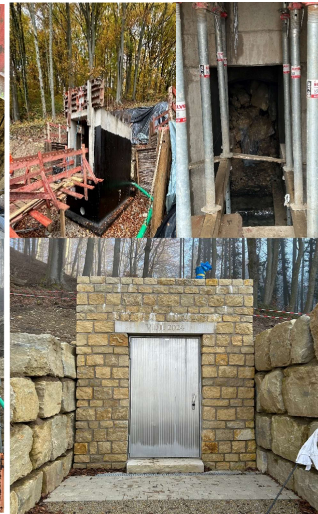
Réhabilitation de l'ancien captage D01 (Copyright: Ville de Luxembourg)
