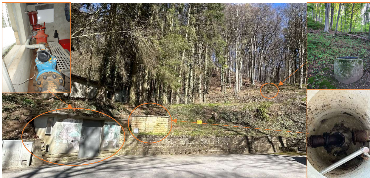
Situation avant le début des travaux. Copyright: Ville de Luxembourg
