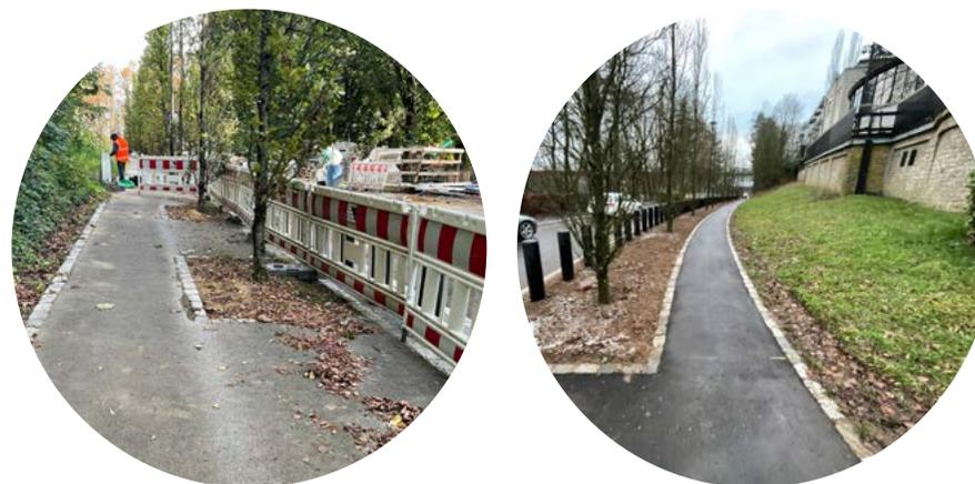
Figure 9 : Exemple Bvd Paul Eyschen avant et après travaux de réduction de scellement - Source : Service Voirie
